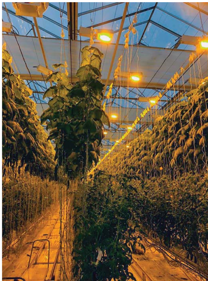
Рис.5. Светильники с лампами сориентированы поперек рядов растений Fig. 5. Lamps with lamps are oriented across the rows of plants
