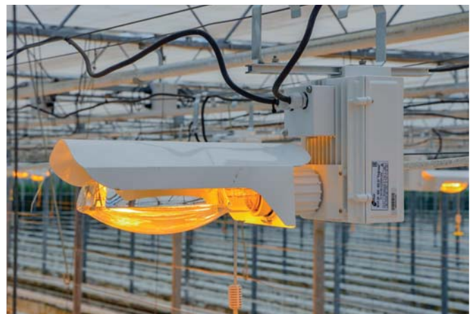
Рис.4. Светильник ЖСП 25 «Рефлекс» с ЭПРА и лампа ДНаЗ/Reflux создают единый тепличный облучатель Fig. 4. ZhSP 25 «Reflux» lamp with electronic ballast and DNaZ / Reflux lamp create a single greenhouse illuminator
